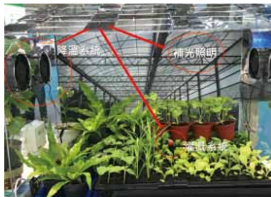
圖二、屋頂式營農型綠能農業設施示意圖，設施內的各項用電可由上方的太陽能板產電自用，餘電再行售出，達到真正農電農用，綠電加值之原則。
