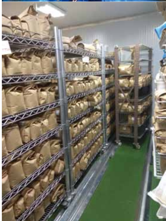
圖二、IRRI種原庫乾燥室，收穫種子以網袋進行第一次乾燥(上)，精選後以紙袋包裝進行第二次乾燥(下)。乾燥室溫度15°C，相對溼度15%。
