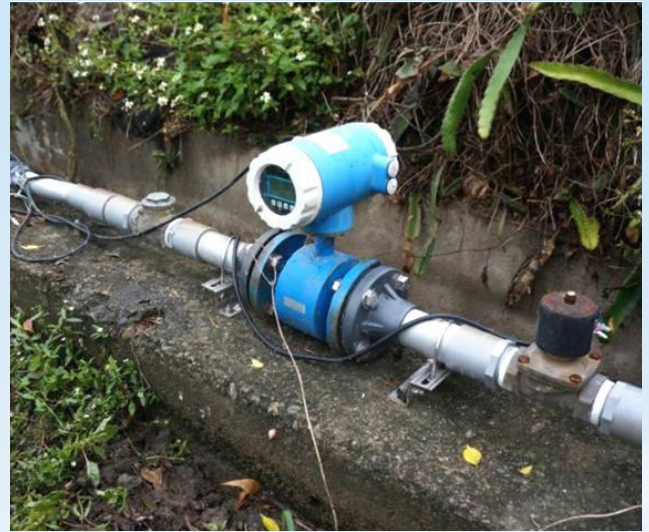
圖三、通訊型水錶，可透過手機遙控水閥開關。
