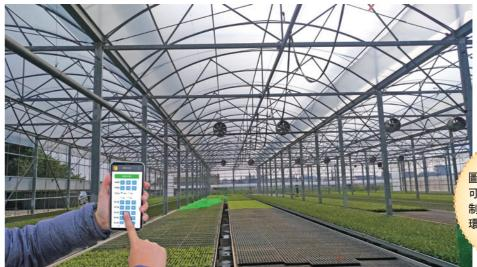
圖1.遠端程控系統 可透過智慧型手機控 制設施內遮蔭網、循 環風扇等設備
