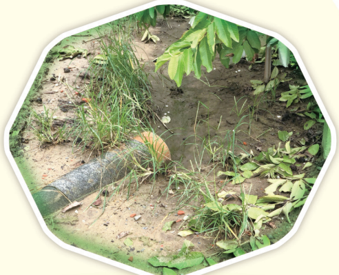
豪大雨過後應確保田區排水溝暢通，以利排水，避免造成植株衰亡或腐爛。
