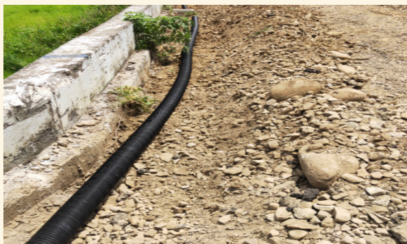
雨水截水溝和 HDPE 網管
