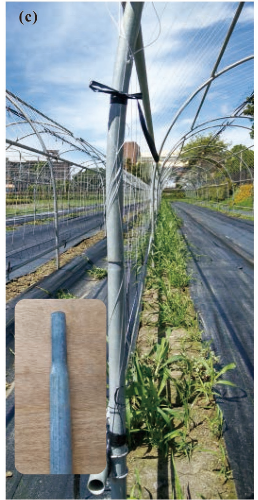
圖1. (a)隧道式棚架規格圖；(b)拱型架及橫向連接桿之田間搭設示意圖；(c)連接桿一端或拱形架撓折處，可請工廠於製做縮頭，方便於田間搬運及組裝。
