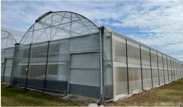
圖二、強固型圓頂力霸塑膠型網室具有抗強風之特性。
