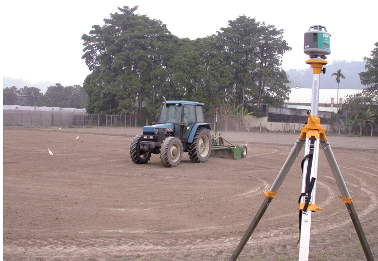
圖一、田間組合雷射整平作業。
