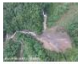
圖 6 UAV 現場照片
