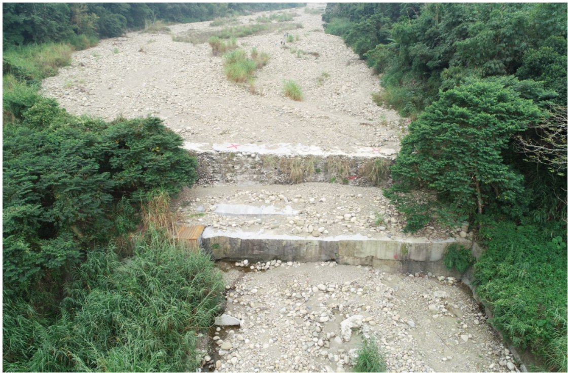
圖 4-36 第二號防砂壩(現地照片 1)
