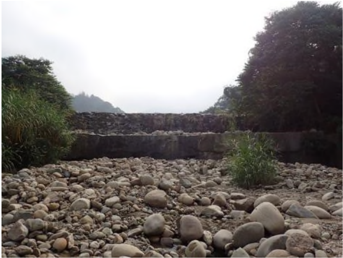
圖 4-37 第二號防砂壩(現地照片 2)
