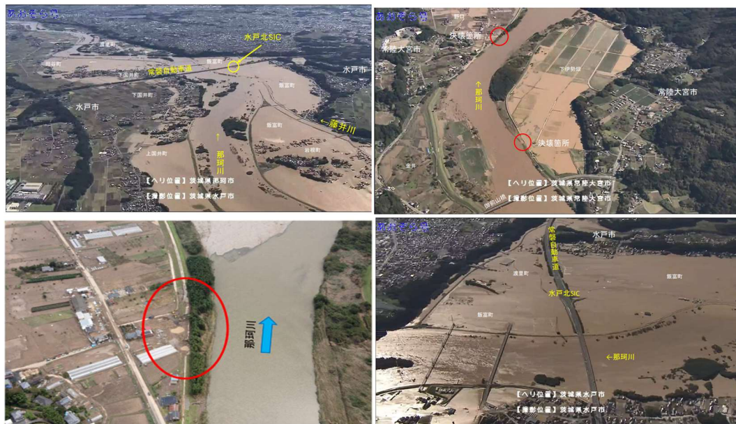
圖 5-17 那珂川堤防潰決淹水災害（國土交通省 關東地方整備局，2020)
