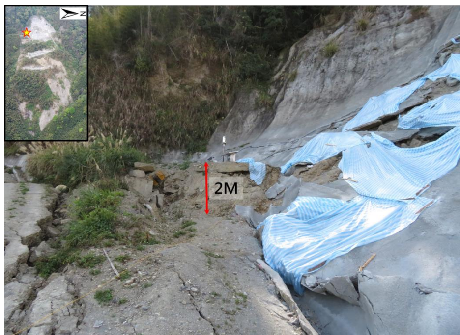
圖 3- 7 子崩崖崖面落差明顯 (拍攝日期 2021/02/23，拍攝方位角 180 度)
