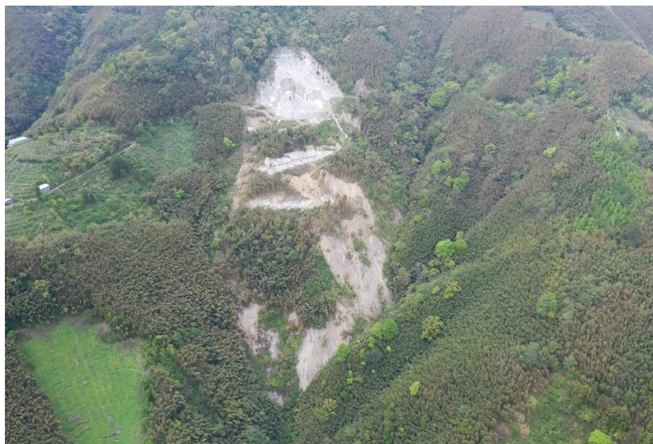
圖 3- 9 T002 之現生崩塌地 (拍攝日期 2021/3/17)
