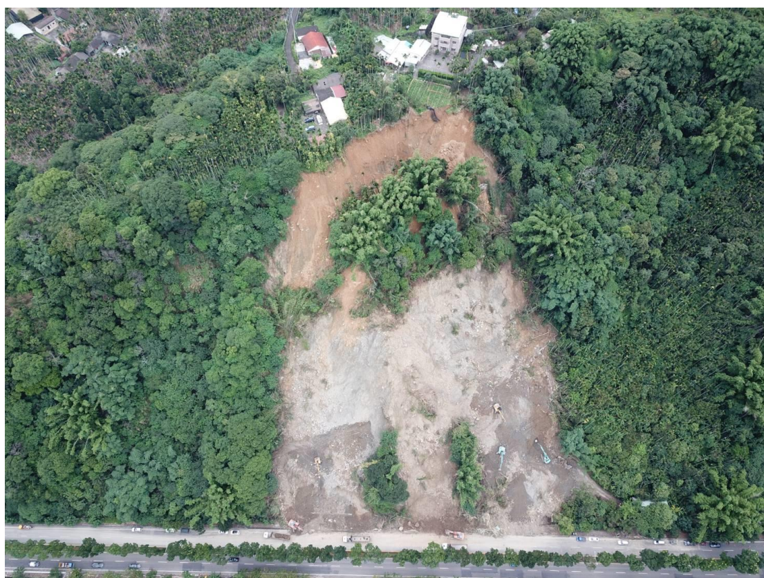
圖 3-45 集集崩塌地全貌 (南投分局提供)
