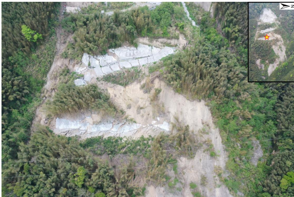
圖 3- 12 右側坡腹明顯現生崩塌裸露地 (拍攝日期 2021/3/30)
