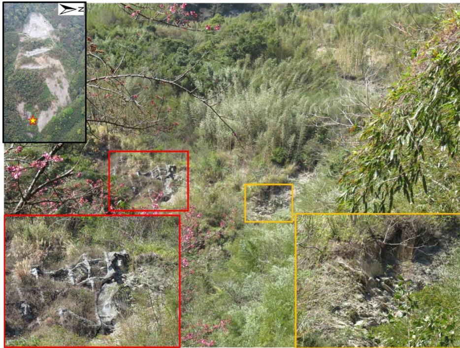
圖 3-8 坡趾處地形特徵。左側邊坡 (紅框) 格樑護坡隆起及破壞；右側邊坡 (橘框) 有現生裸露崩塌地 (拍攝日期 2021/02/23，拍攝方位角 270 度)
