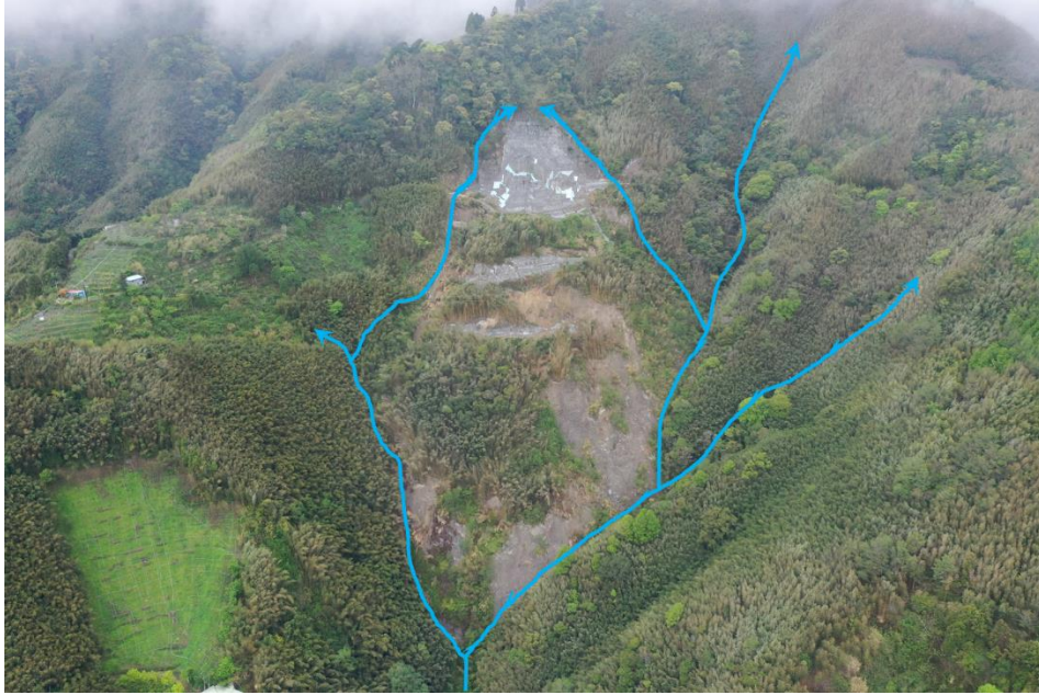
圖 3- 15 坡面侵蝕溝地形特徵，已發育雙溝同源特徵 (拍攝日期： 2021/03/22)
