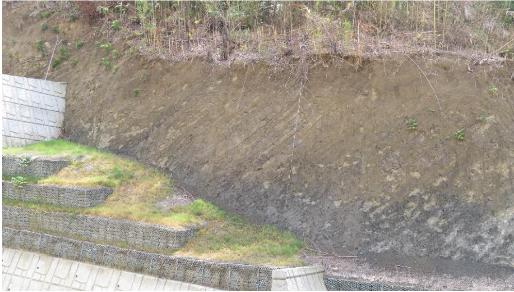
圖 3- 27 投縣 DF126 左側邊坡
