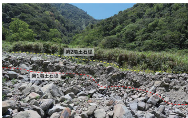
圖 10. 調查點②土石堤縱剖面
