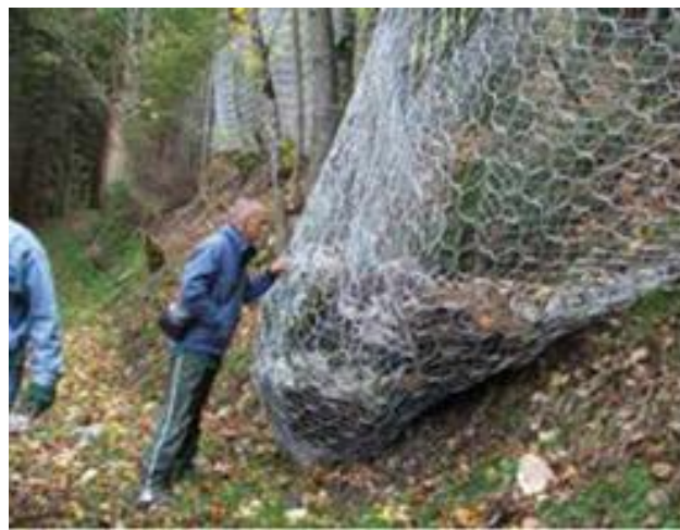
圖 2.5.4 工程保護落石金屬防護網示意圖(防治局)
