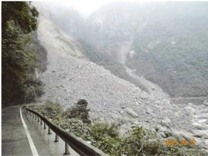
圖 3.4.3 台 8 線 181.4 K 邊坡大規模崩坍示意圖(公路總局)
