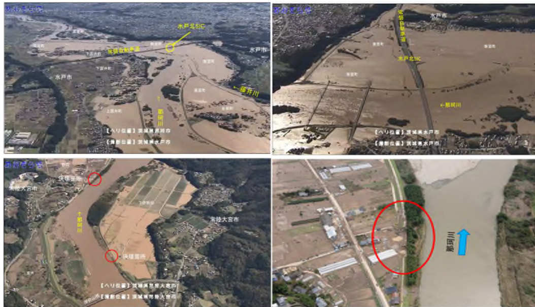
圖 3-14 那珂川堤防潰決淹水災害 (國土交通省 關東地方整備局， 2020，令和元年台風第 19 号を踏まえた「那珂川緊急治水対策プロ ジェクト」を開始します)
