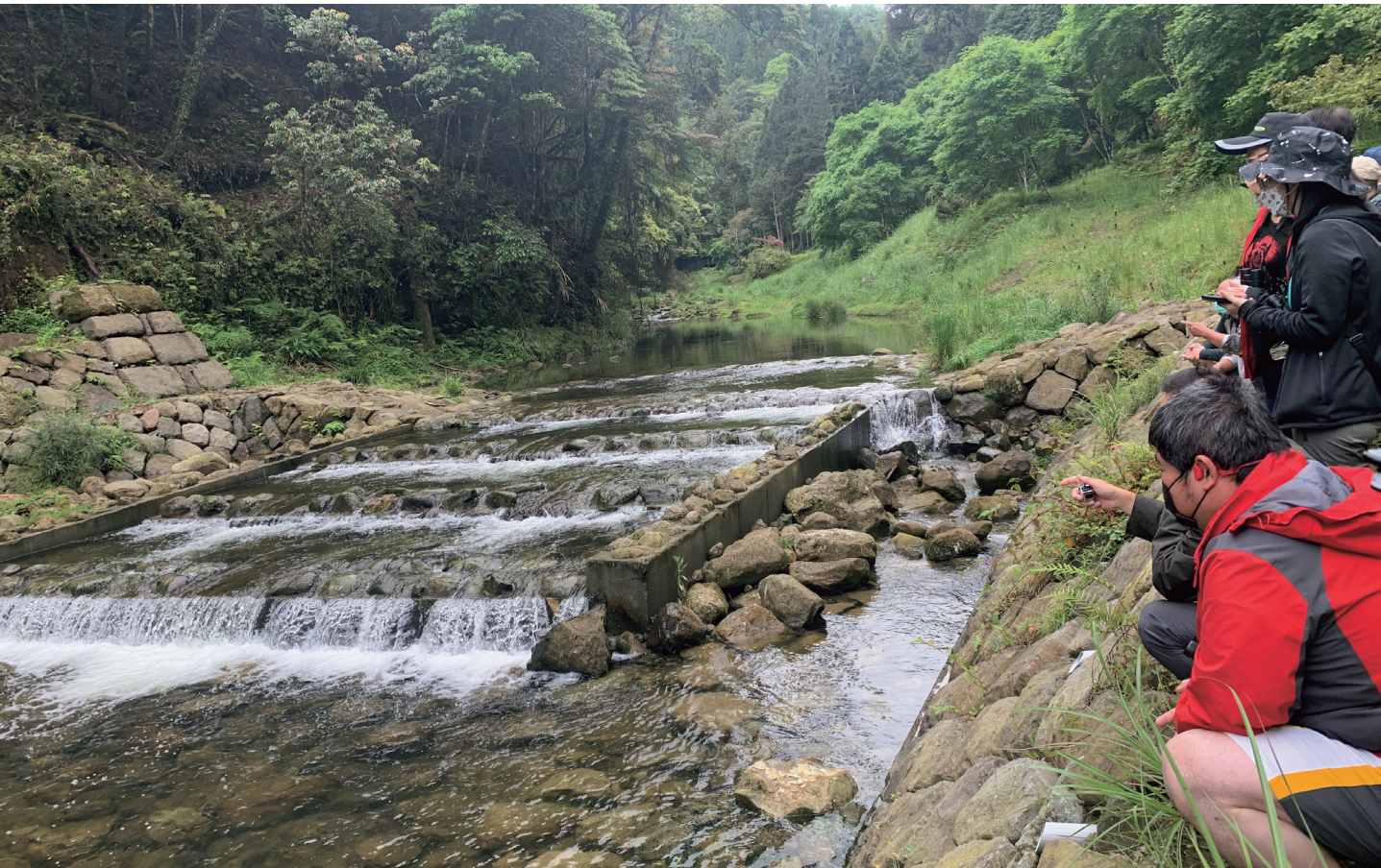
工程人員們在加走寮溪畔，觀察河床中的連續跌水設施，計算有多少隻魚類嘗試跳躍溯游而上。
