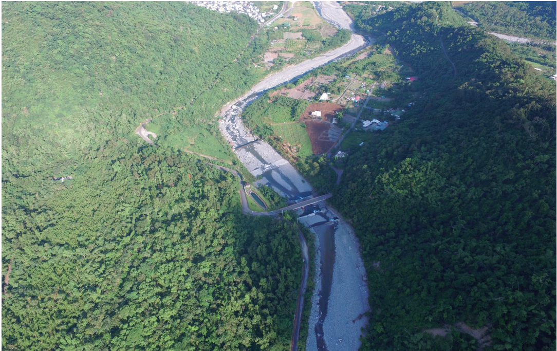
⑩ 大南北溪河道通洪斷面檢視
