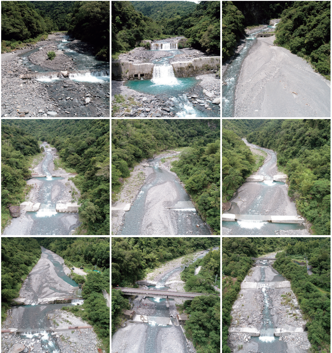
⑮ 大南北溪構造物現況 (2021年12月)
