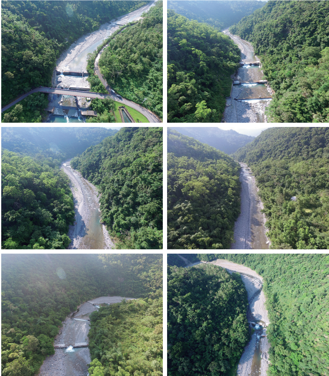
⑧ 大南北溪河道構造物與河道堆積狀況
