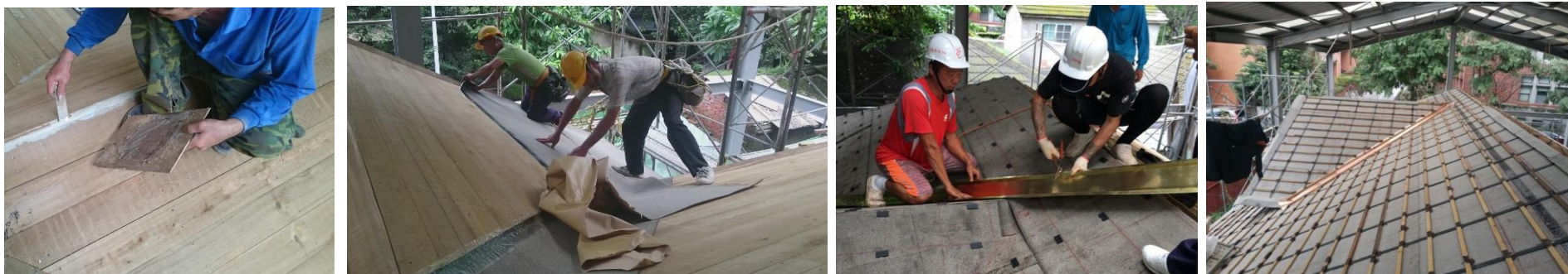
■ 屋面修復 – 節點、破孔以樹脂填補 --> 鋪設防水毯及試水 --> 黃銅谷溝 --> 安裝洩水條與掛瓦條
