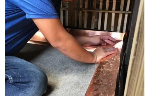
■ 雨庇修復 – 雨庇木結構修復 --> 鋪設防水毯及試水 --> 安裝泛水木料 --> 泛水包覆銅皮
