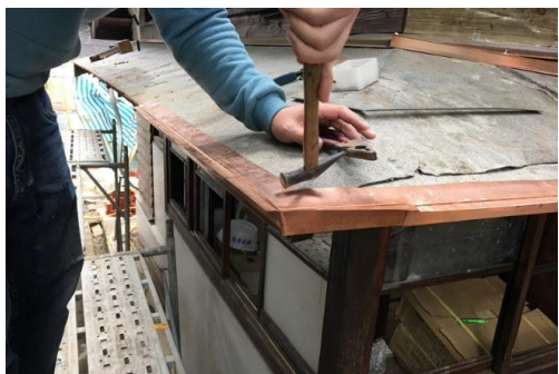
■ 雨庇修復 – 滴水施作 --> 銅板瓦鋪設 --> 谷溝鋪設 --> 壓實、清潔
