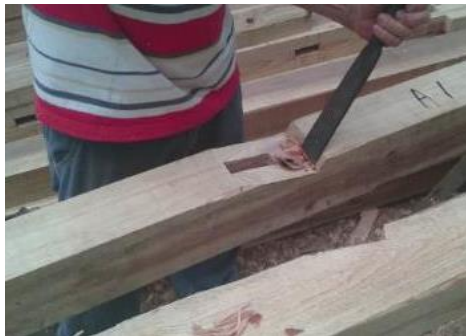
■ 屋架修復 – 木料編號/放樣 --> 開榫加工 --> 構件組裝
