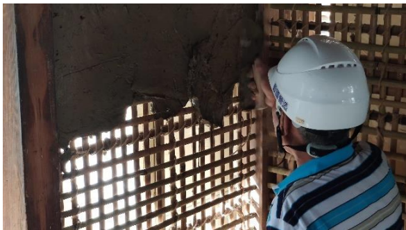
■ 白灰壁修復 - 底塗 --> 中塗 --> 面塗
