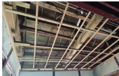
■ 竿緣天花修復 – 木料檢修/開榫 --> 骨架及竿緣組裝 --> 天花板組裝及噴塗護木漆
