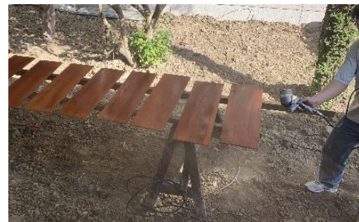
■ 竿緣天花修復 – 木料檢修/開榫 --> 骨架及竿緣組裝 --> 天花板組裝及噴塗護木漆
