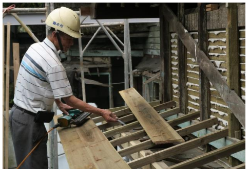
■ 雨庇修復 – 雨庇木結構修復 --> 鋪設防水毯及試水 --> 安裝泛水木料 --> 泛水包覆銅皮
