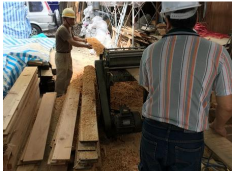
■ 木地板修復 – 木料檢修/開榫(文武榫)--> 木料組裝 --> 表面打磨 --> 塗刷保護漆
