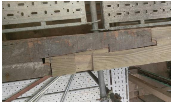
■ 舊木料再利用 – 切除/整修損壞部分 --> 重新開榫 --> 新舊組裝/蹲接
