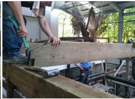
■ 舊木料再利用 – 切除/整修損壞部分 --> 重新開榫 --> 新舊組裝/蹲接
