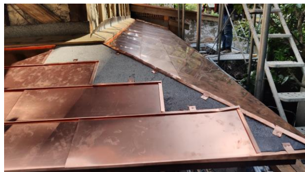
■ 雨庇修復 – 滴水施作 --> 銅板瓦鋪設 --> 谷溝鋪設 --> 壓實、清潔
