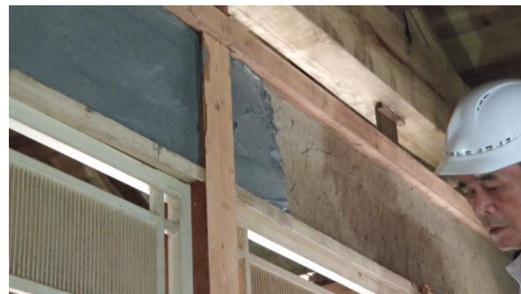
■ 養灰 - 養灰池建置 --> 拌入麻絨與稻梗 --> 拌入熟石灰 --> 定期攪拌
