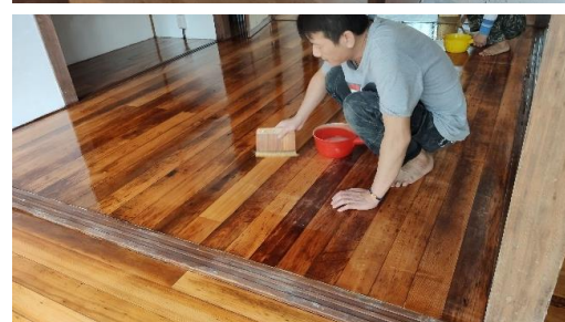
整體平整打磨及塗佈保護漆
