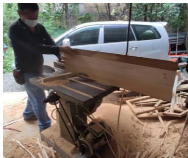
■ 竿緣天花修復 – 木料檢修/開榫 --> 骨架及竿緣組裝 --> 天花板組裝及噴塗護木漆
