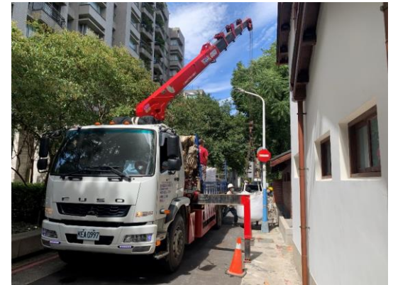
進場材料吊掛
