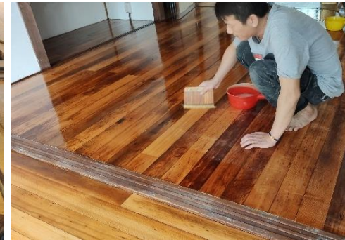
■ 木地板修復 – 木料檢修/開榫(文武榫)--> 木料組裝 --> 表面打磨 --> 塗刷保護漆
