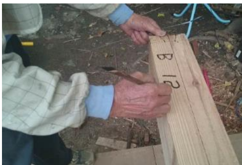
■ 屋架修復 – 木料編號/放樣 --> 開榫加工 --> 構件組裝
