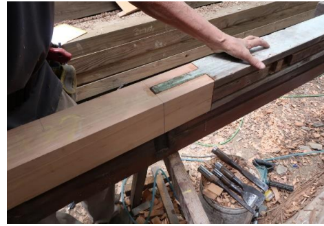
■ 舊木料再利用 – 切除/整修損壞部分 --> 重新開榫 --> 新舊組裝/蹲接
