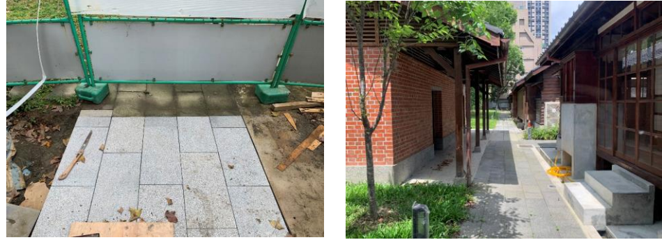
雙數號22.24.28.30.34號後側通路分次施工串聯
