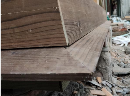
■ 雨淋板修復 – 木料打磨 --> 安裝雨押 --> 交疊方式鋪設雨淋板 --> 安裝押緣 --> 塗刷護木漆
