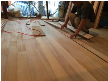
■ 木地板修復 – 木料檢修/開榫(文武榫)--> 木料組裝 --> 表面打磨 --> 塗刷保護漆
