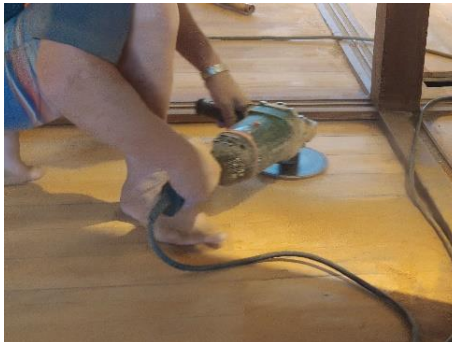
■ 木地板修復 – 木料檢修/開榫(文武榫)--> 木料組裝 --> 表面打磨 --> 塗刷保護漆
