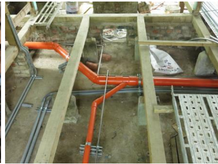
■ 機電設備更新 / 管線配置 / 增設強制出迴風空調設備
