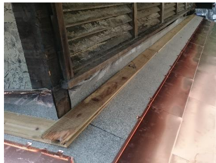
■ 雨庇修復 – 雨庇木結構修復 --> 鋪設防水毯及試水 --> 安裝泛水木料 --> 泛水包覆銅皮
