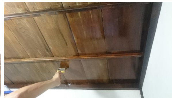
■ 竿緣天花修復 – 木料檢修/開榫 --> 骨架及竿緣組裝 --> 天花板組裝及噴塗護木漆
