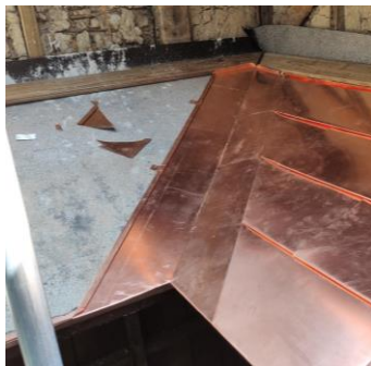
■ 雨庇修復 – 滴水施作 --> 銅板瓦鋪設 --> 谷溝鋪設 --> 壓實、清潔
