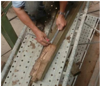
■ 舊木料再利用 – 切除/整修損壞部分 --> 重新開榫 --> 新舊組裝/蹲接
