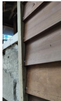
■ 雨淋板修復 – 木料打磨 --> 安裝雨押 --> 交疊方式鋪設雨淋板 --> 安裝押緣 --> 塗刷護木漆
