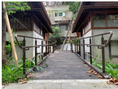
無障礙設施(坡道)
