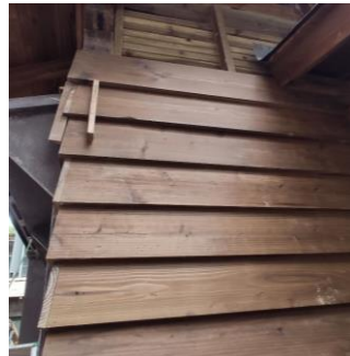
■ 雨淋板修復 – 木料打磨 --> 安裝雨押 --> 交疊方式鋪設雨淋板 --> 安裝押緣 --> 塗刷護木漆
