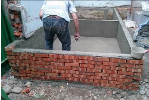
■ 養灰 - 養灰池建置 --> 拌入麻絨與稻梗 --> 拌入熟石灰 --> 定期攪拌
