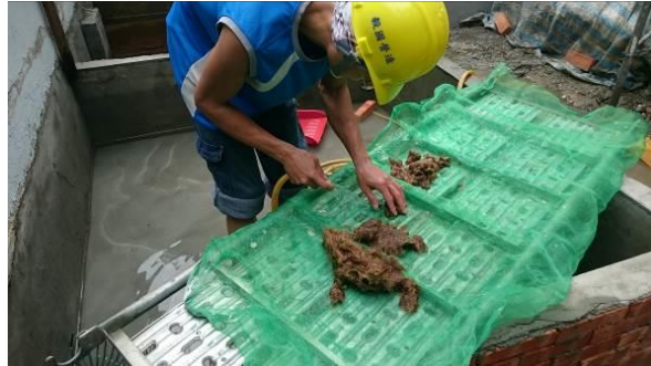
■ 養灰 - 養灰池建置 --> 拌入麻絨與稻梗 --> 拌入熟石灰 --> 定期攪拌
