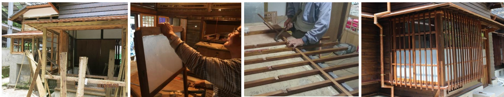
■ 突窗檢修 – 窗框載體去漆/檢修 --> 窗扇新作/修復 --> 千鳥新作/修復 --> 組裝
