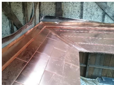
■ 雨庇修復 – 雨庇木結構修復 --> 鋪設防水毯及試水 --> 安裝泛水木料 --> 泛水包覆銅皮
