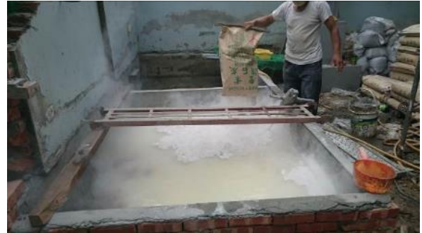
■ 養灰 - 養灰池建置 --> 拌入麻絨與稻梗 --> 拌入熟石灰 --> 定期攪拌
