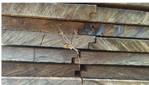
舊木地板整理修補
