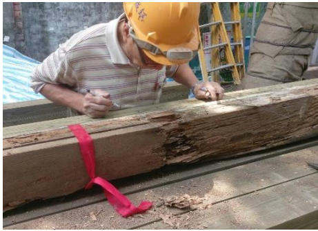
■ 柱樑修復 – 木料編號/放樣 --> 開榫加工 --> 構件組裝
