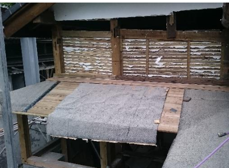
■ 雨庇修復 – 雨庇木結構修復 --> 鋪設防水毯及試水 --> 安裝泛水木料 --> 泛水包覆銅皮
