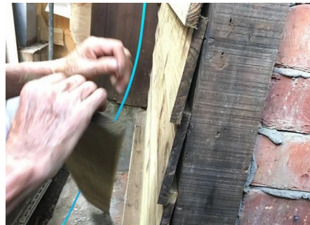
■ 雨淋板修復 – 木料打磨 --> 安裝雨押 --> 交疊方式鋪設雨淋板 --> 安裝押緣 --> 塗刷護木漆
