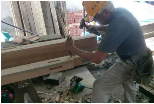
■ 柱樑修復 – 木料編號/放樣 --> 開榫加工 --> 構件組裝
