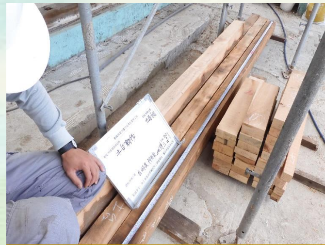
土台施工查驗
