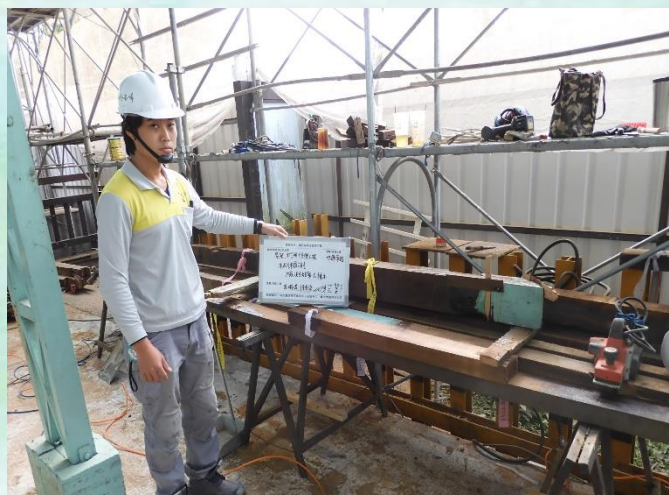
三級整修（修復）施工查驗
