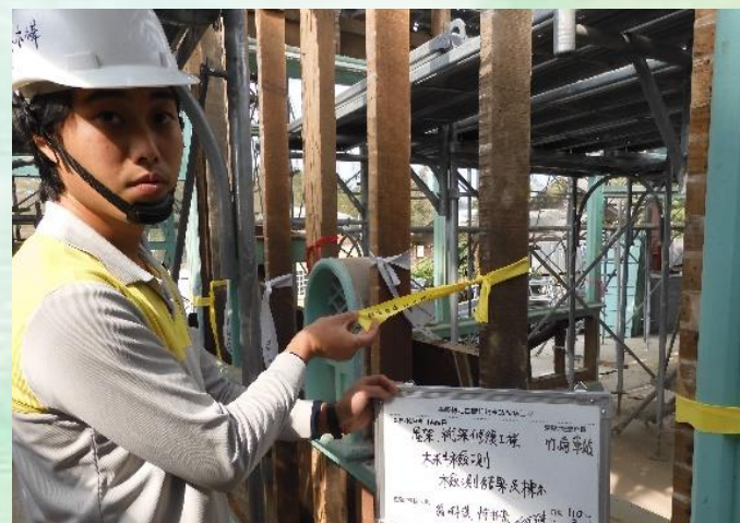
木構件修復分級、標示
