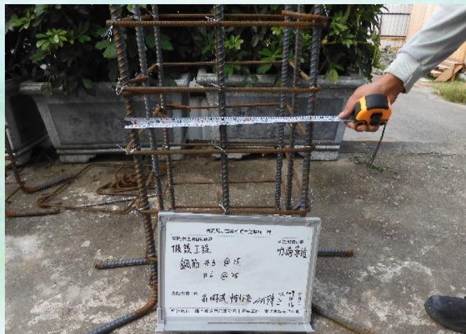
鋼棚架基礎鋼筋施工查驗
