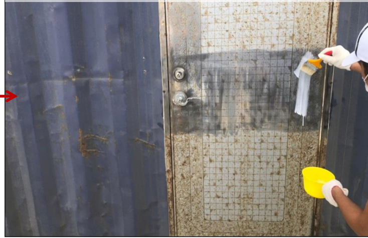
腐蝕擴散制止劑(RS-65)-填充孔隙
