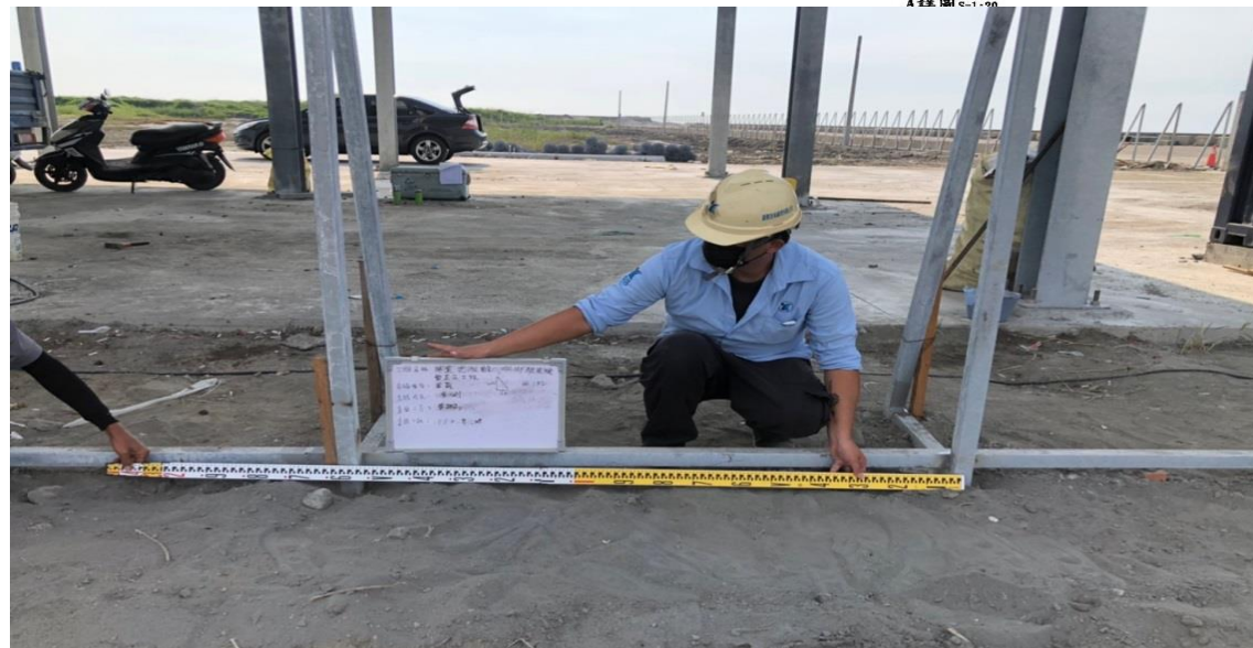
工址位於漁港，故採用50cm*50cm” 鍍鋅” 鋼管(經抽驗皆符合CNS10007 )
