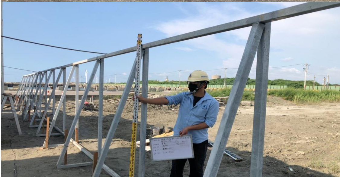
工址位於漁港，故採用50cm*50cm” 鍍鋅” 鋼管(經抽驗皆符合CNS10007 )
