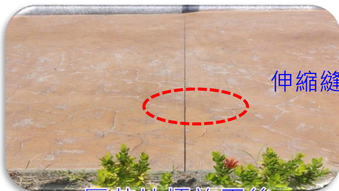
壓花地坪施工後
