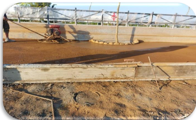
壓花地坪施工
