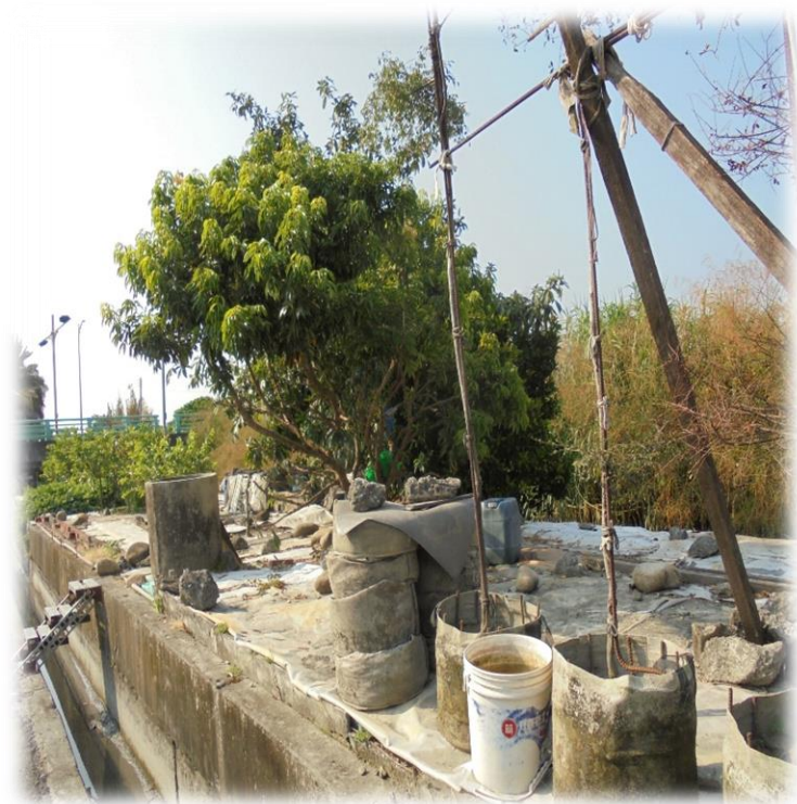
施工前閒置空間
