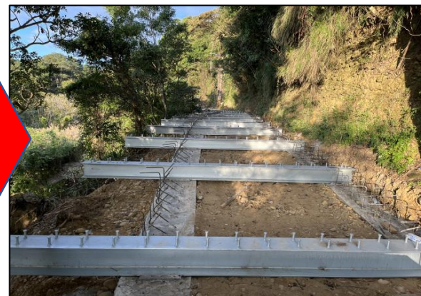
H型鋼銲接及設置
