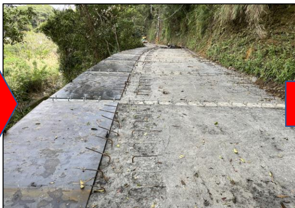
懸臂側鐵板銲接及設置
