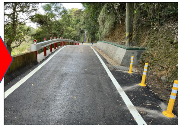
AC路面鋪設
