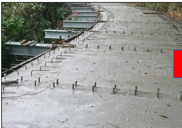
H型鋼間路基施作
