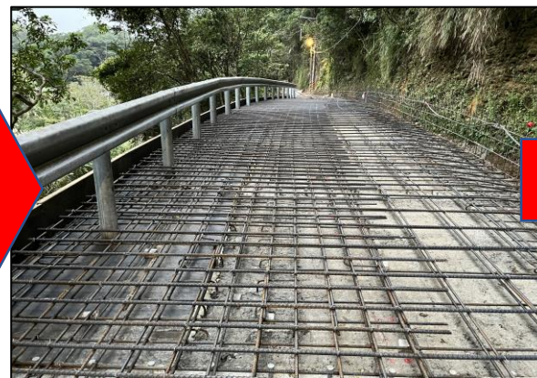
鋼板護欄及路面鋼筋
