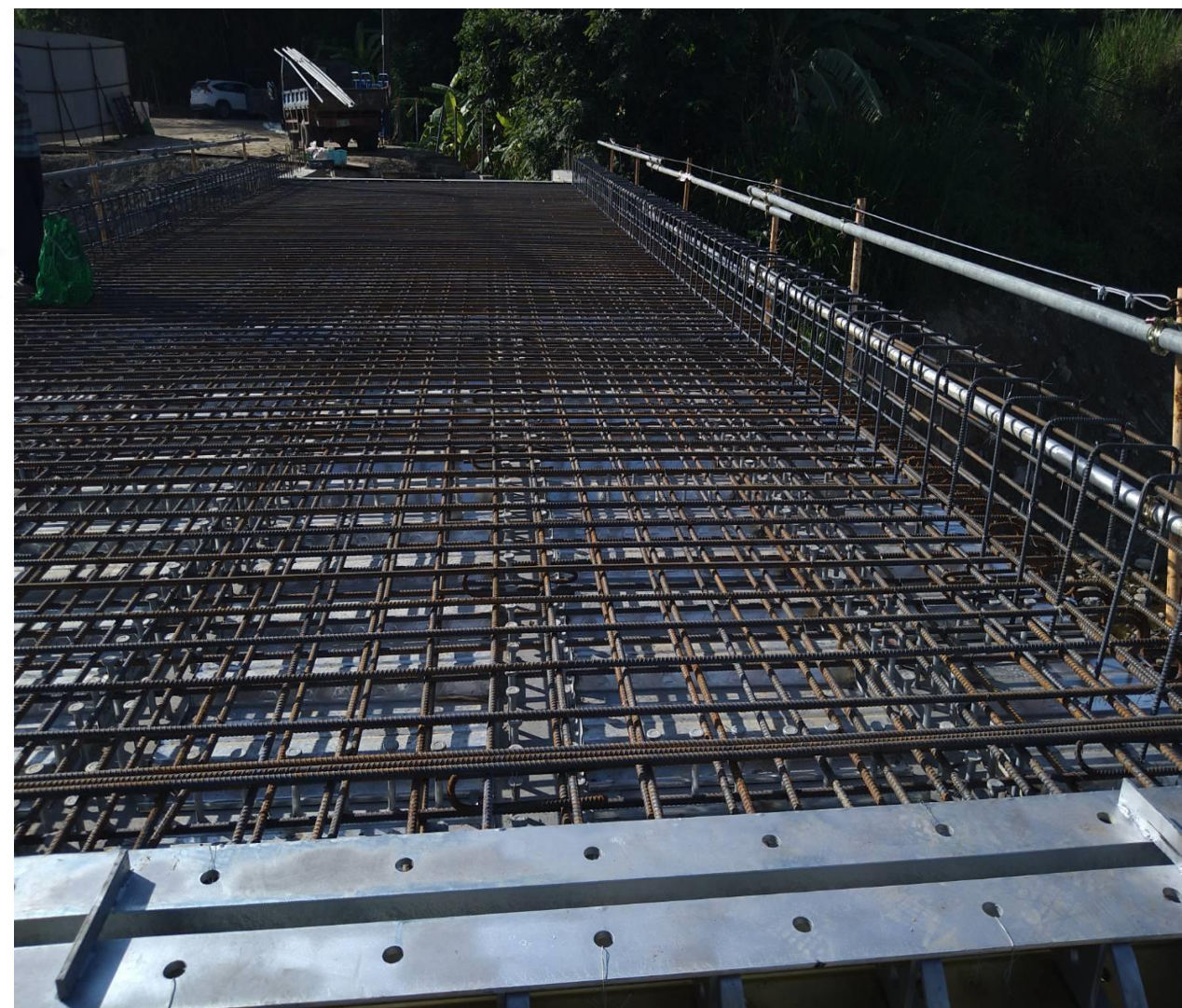
橋面板鋼筋綁紮及模板組立
