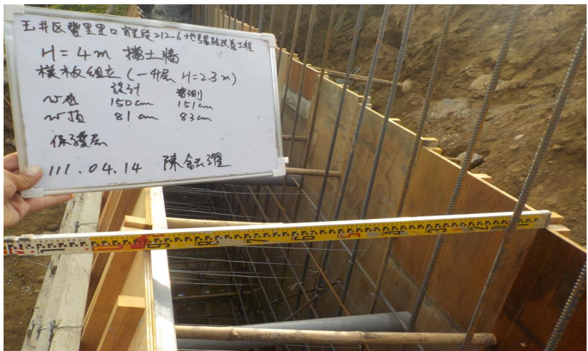
擋土牆模板組立
