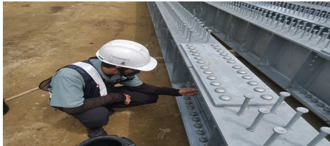
H型鋼剪力釘檢查
