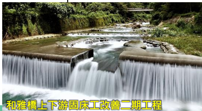
和雅橋上下游固床工改善二期工程
