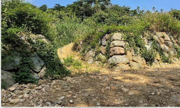
1 支流銜接(土溝)
