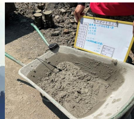
混凝土氯離子檢測
