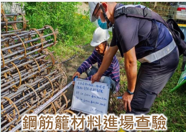
鋼筋材料進場查驗
