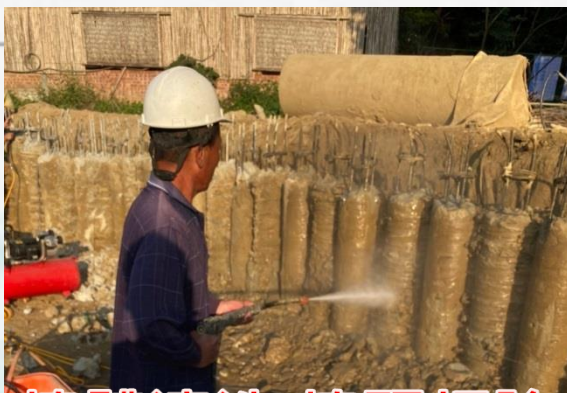
樁體清洗 樁頭打除
