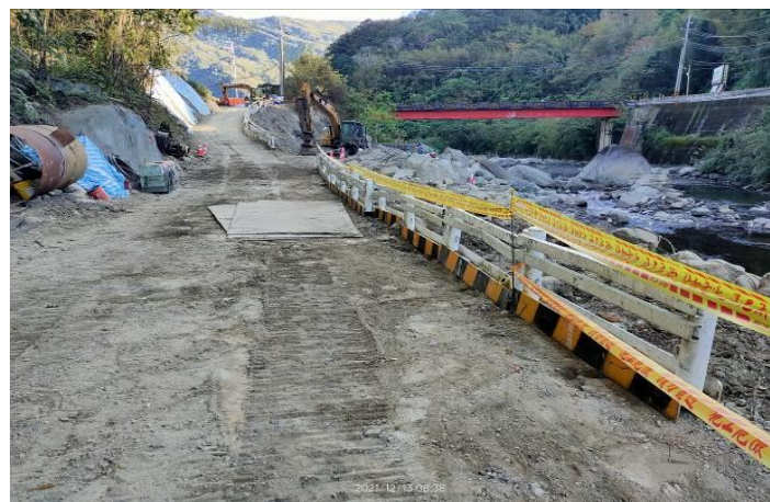
便道安全佈設情形
