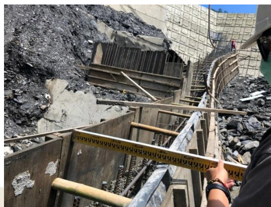
鋼筋及模板查驗
