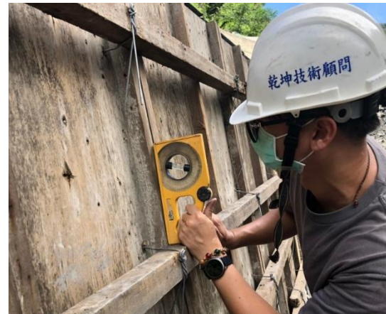
護岸坡度查驗
