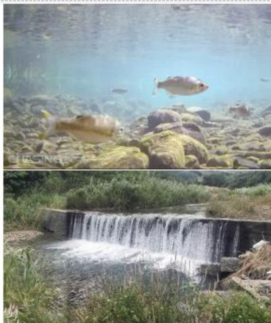
古國水保局臺東分局五福谷溪防砂壩工程改善壩體高度，提供洄游性水生動物友善生態環境。左圖為五福谷溪防砂壩壩體改善前，右圖為壩體改善後，壩體高度降低，提供洄游性水生動物友善生態環境。提供：水保局臺東分局
