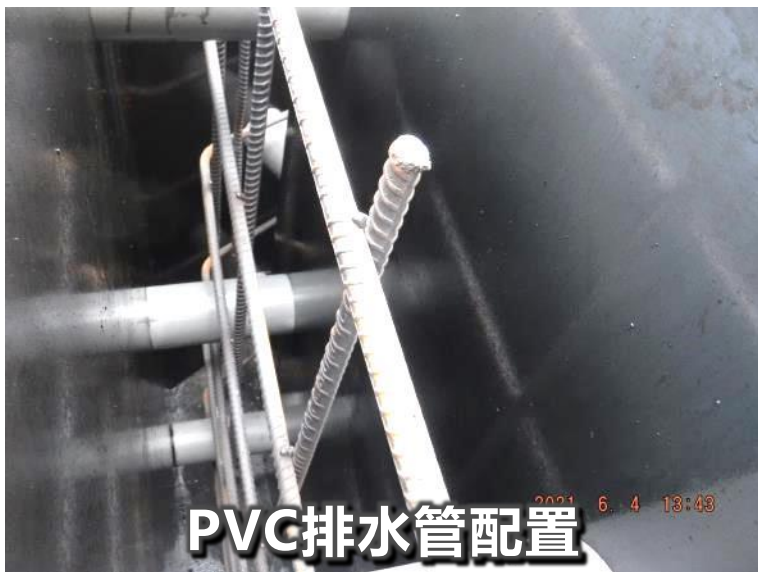
鋼筋綁紮尺寸抽查
