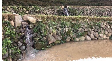
避免出水口與田埂距離過短產生田埂沖刷
