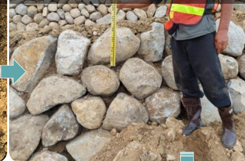
砌石護坡高度自主檢查
