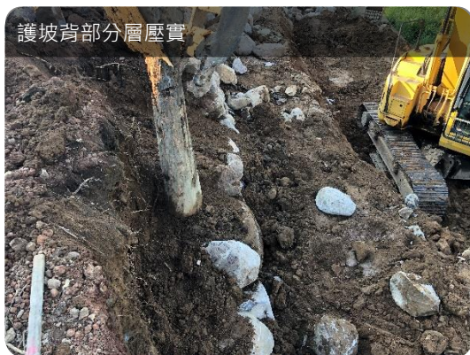
田埂、牛踏層一起施工，減少滲水側面滲流
