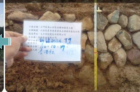
砌石護坡高度自主檢查
