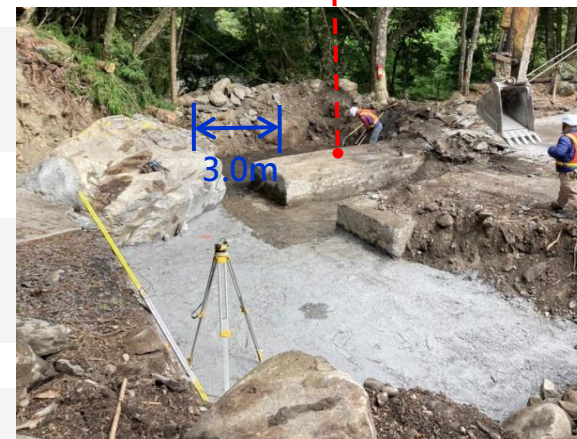
以植筋方式連結舊吊橋主索錨錠 基礎方式施作
