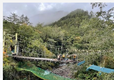
5 拆除舊橋上部結構
