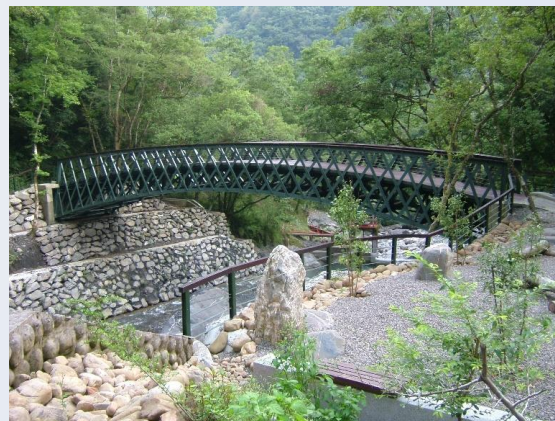
第二代 桁架鋼橋 民國97
