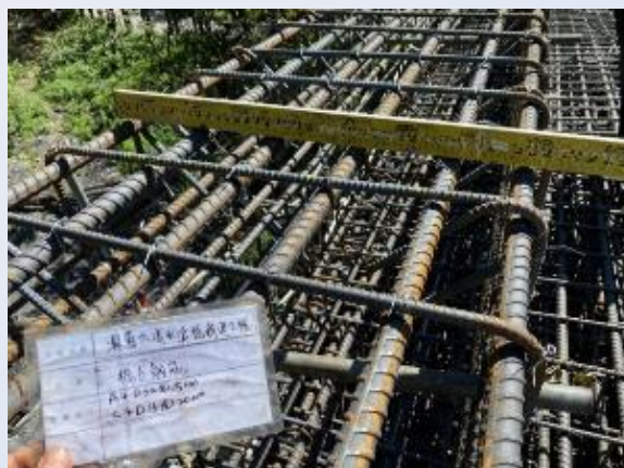
橋台鋼筋尺寸檢查
