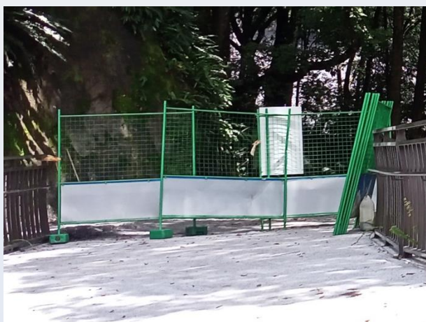
路口施工圍籬
