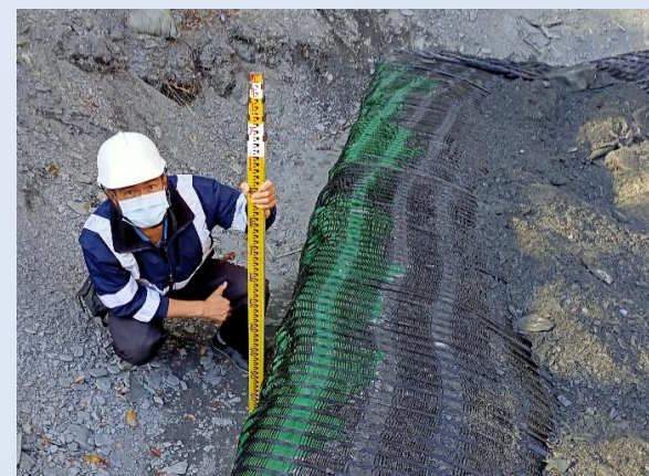
加勁路堤檢查
