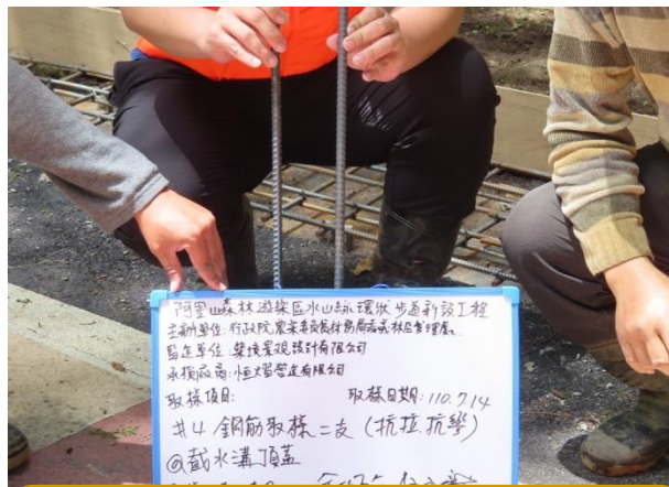
鋼筋取樣試驗
