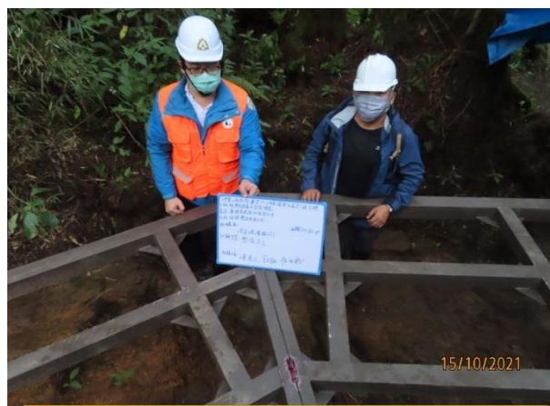
鋼構現場焊道試驗
