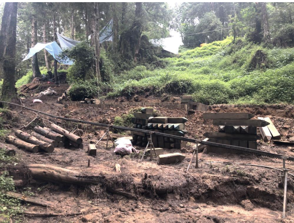
架設單軌車軌道
