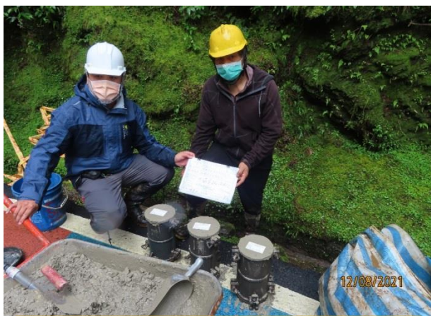
預拌混凝土取樣試驗
