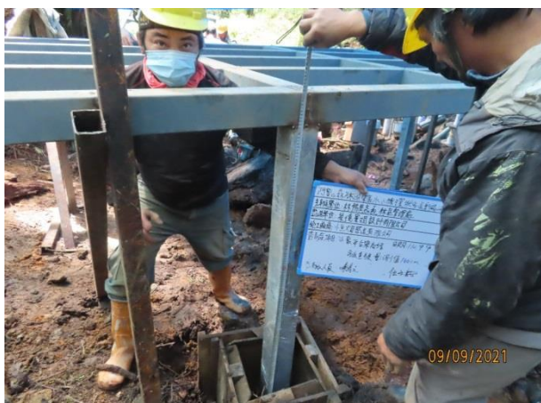
鋼構基礎深度查驗
