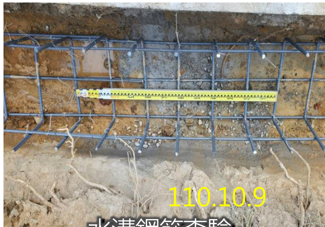
110.10.9 水溝鋼筋查驗
