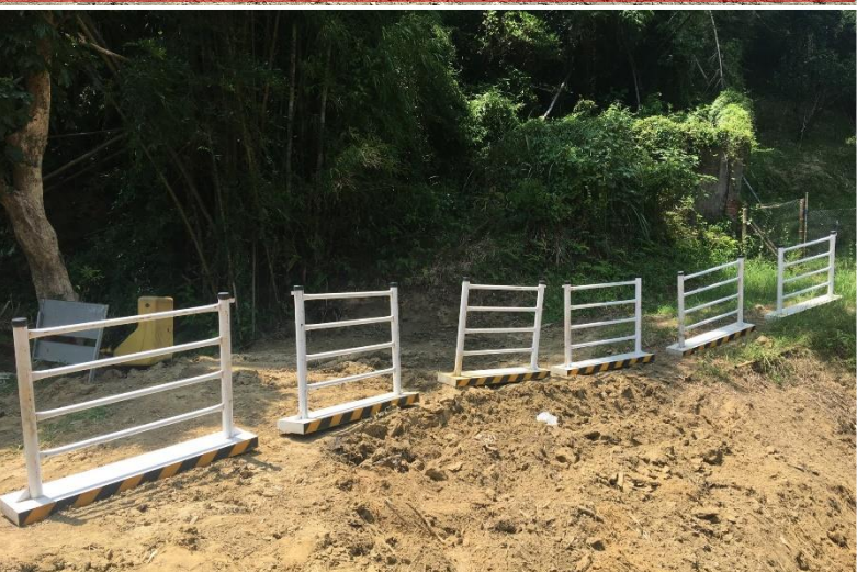
限縮工程範圍，不破壞周遭林相
