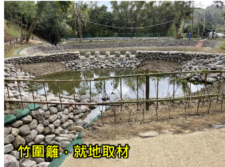
淤泥自拌護岸 (二層) 就地取材 減少水泥用量
