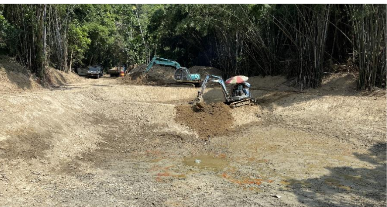
限縮工程範圍，不破壞周遭林相
