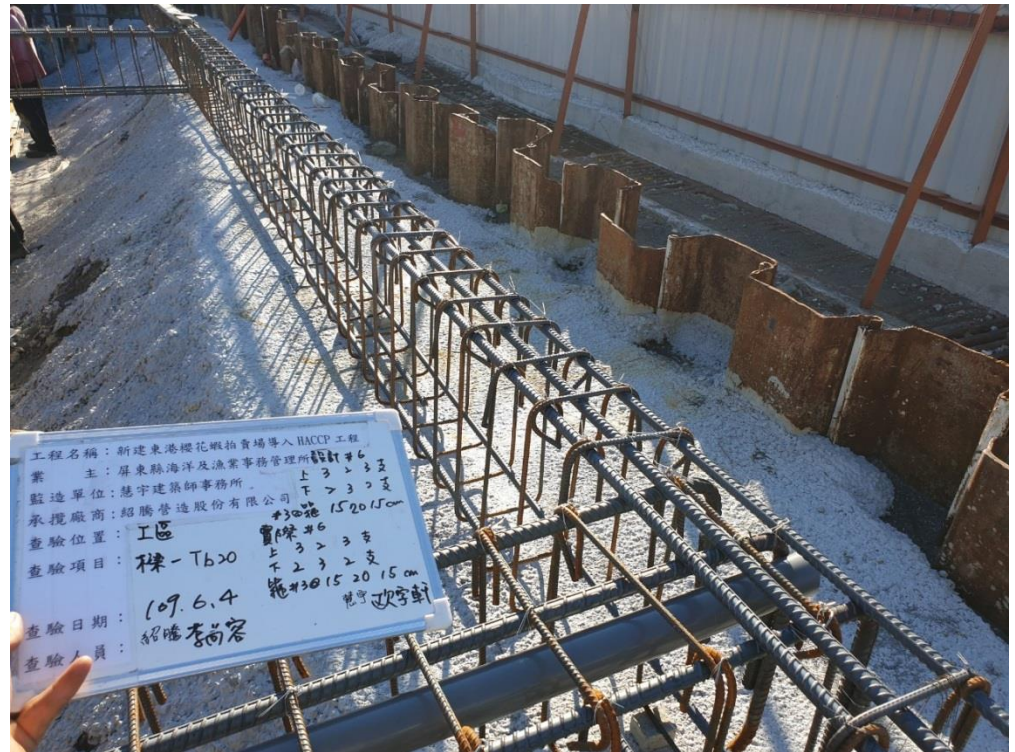
□ 臨時擋土設施-U型鋼板樁
