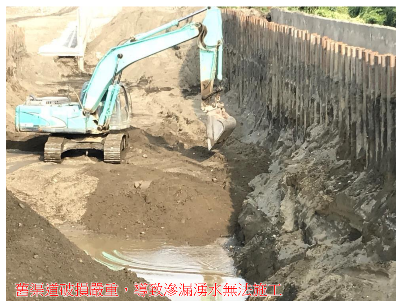
增設鋼板樁形成封閉區塊配合點井，以利工進
