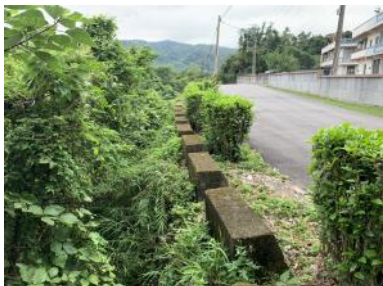
9.1K+340房舍外圍擋土牆
