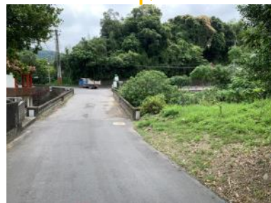
5.1K+250道路及側邊空地
