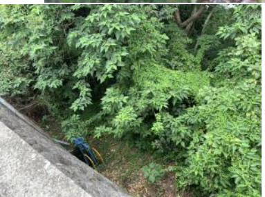
8.1K+300閘門及排放口
