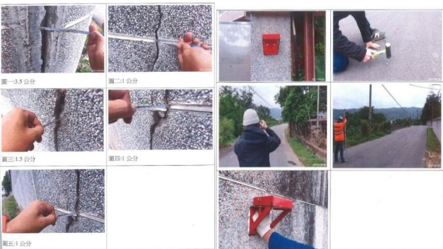
安裝與量測照片
