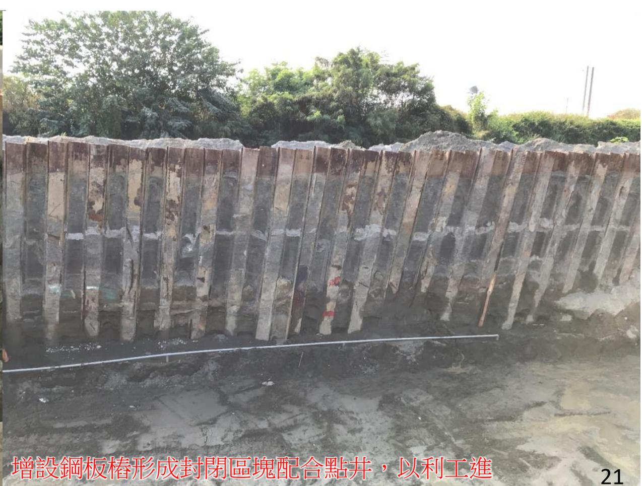
增設鋼板樁形成封閉區塊配合點井，以利工進
