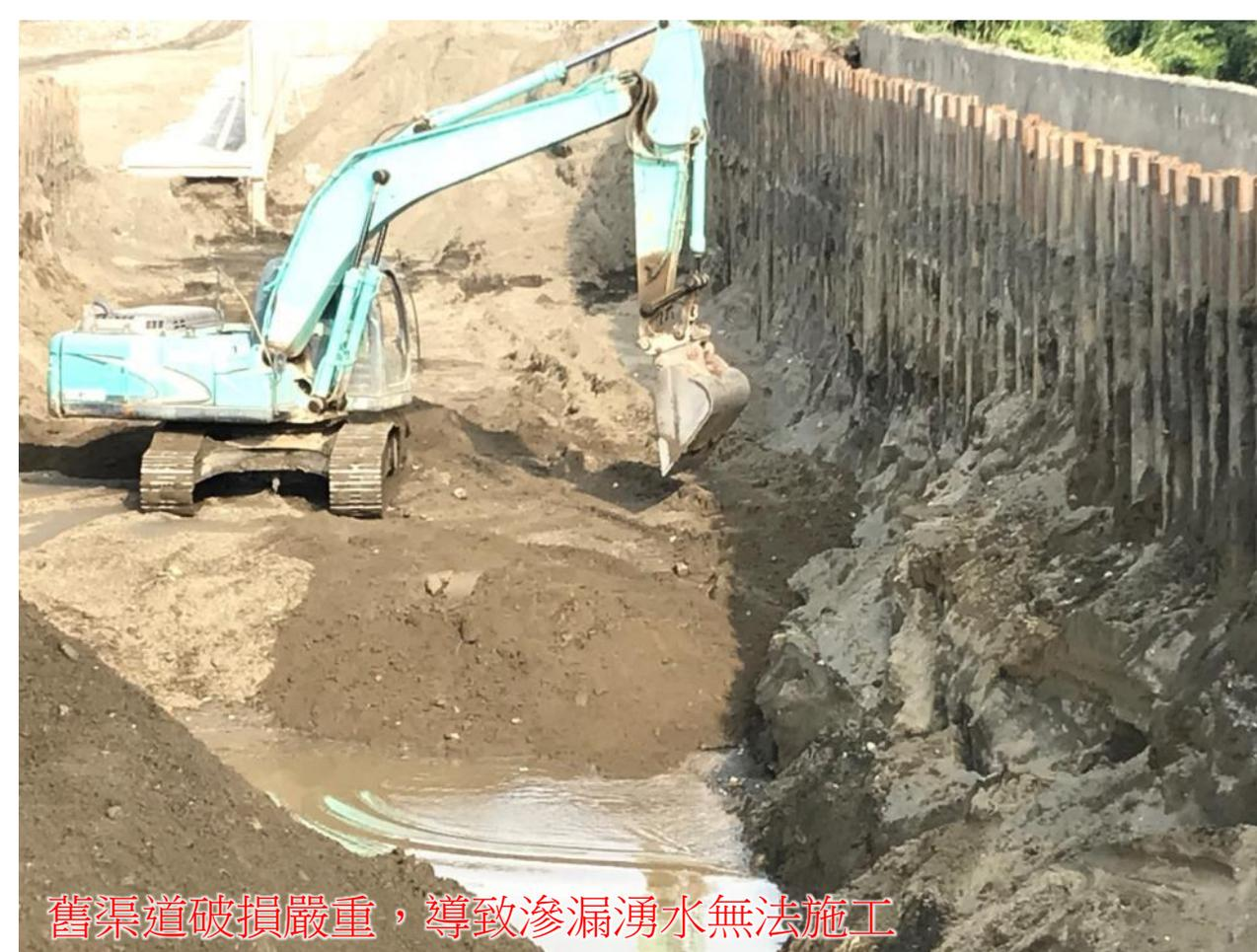
舊渠道破損嚴重，導致滲漏湧水無法施工
