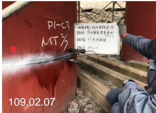
防撞鋼版焊道檢測
