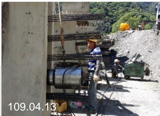
預力梁施拉預力
