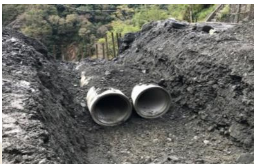
施工便道下方設置排水涵管
