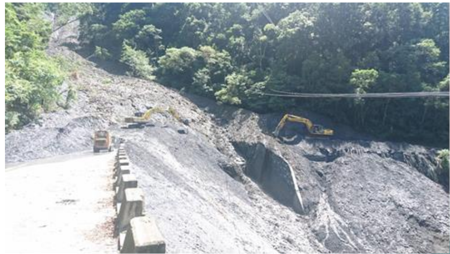
106年6月7日大量土砂下移將箱涵掩埋 (106.6.12)
