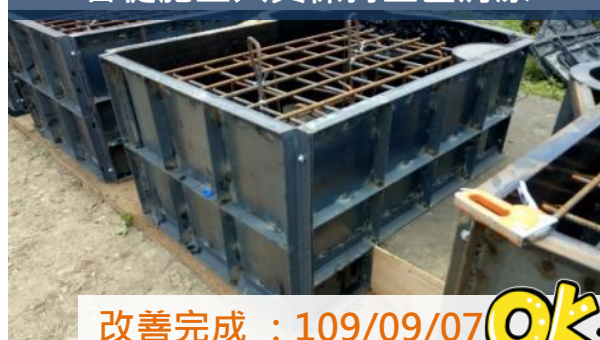
督促施工人員保持工區清潔
