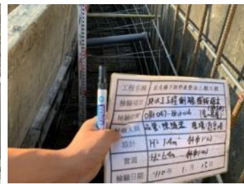
跌水消能工模板檢查
