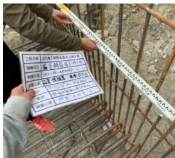
預鑄塊鋼筋檢查
