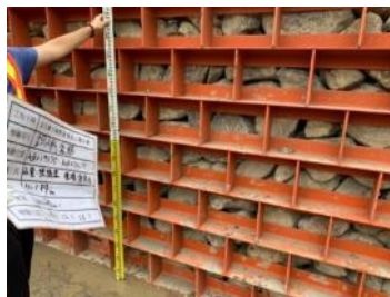
調節設施鋼柵檢查
