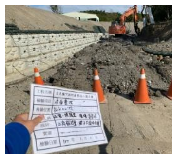
坡腳保護工開挖檢查
