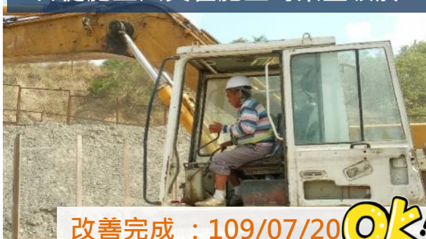
督促施工人員在施工時禁止吸菸
