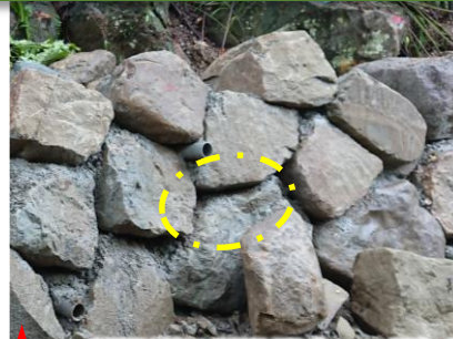
▲ 圍砌原則、孔隙、斜率、砌石面平順
