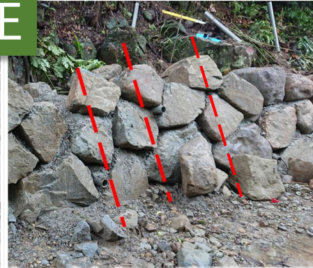
▲ 圍砌原則、孔隙、斜率、砌石面平順
