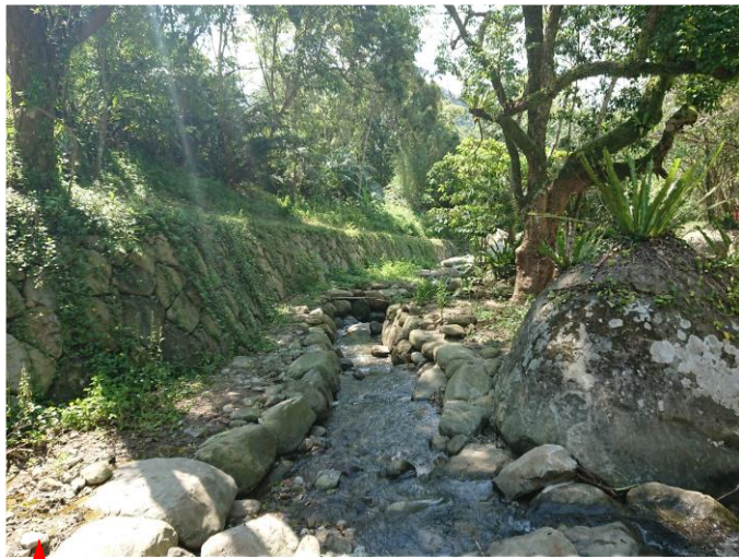
▲ 護岸及導水工情形良好
