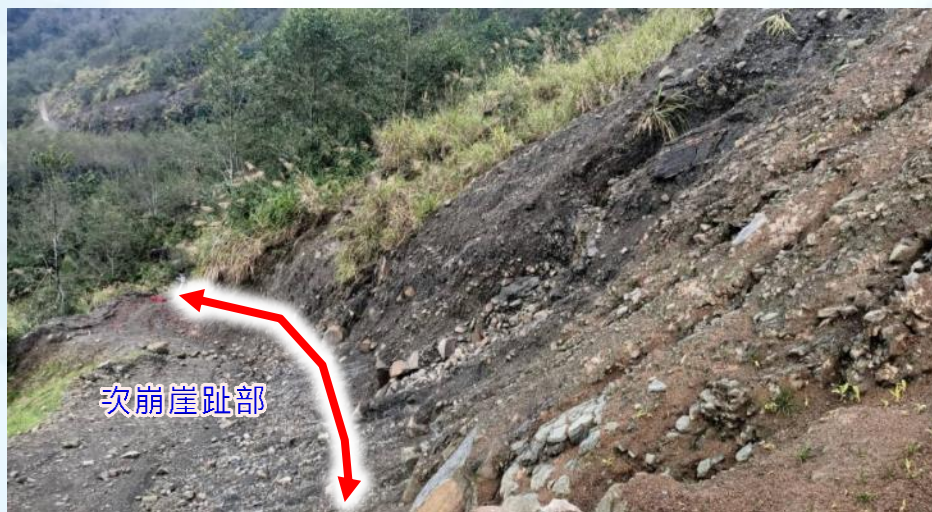
次崩崖趾部坡度陡峭，邊坡不穩定
