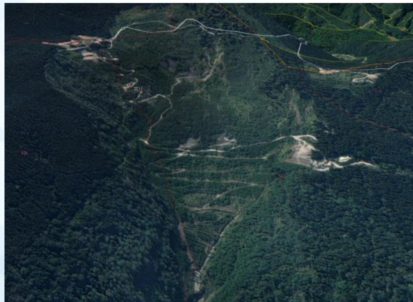
110年7月-二萬坪崩塌地空拍照片
