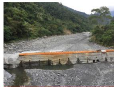
5號防砂壩現況照片
