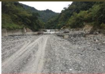
4號防砂壩現況照片
