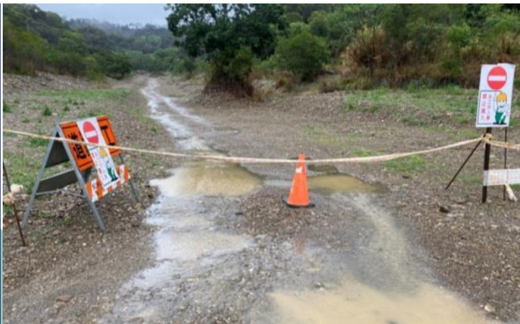
工地出入口管制
