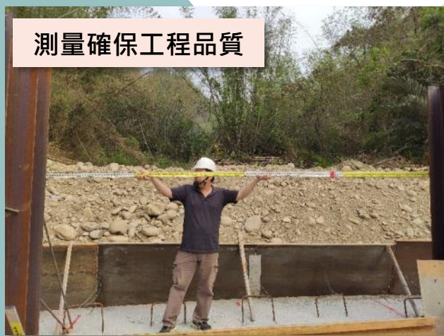
H型鋼組裝測試
