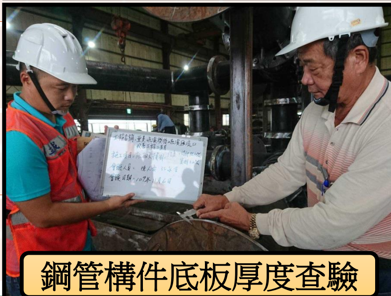
鋼管構件底板尺寸查驗
