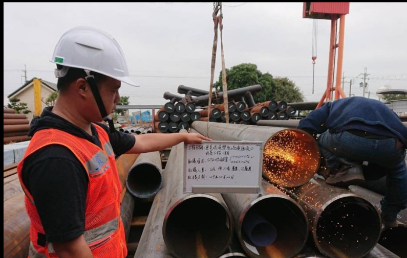
鋼管材質取樣
