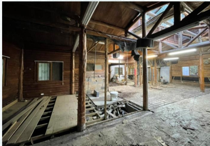
施工前 生態擾動
