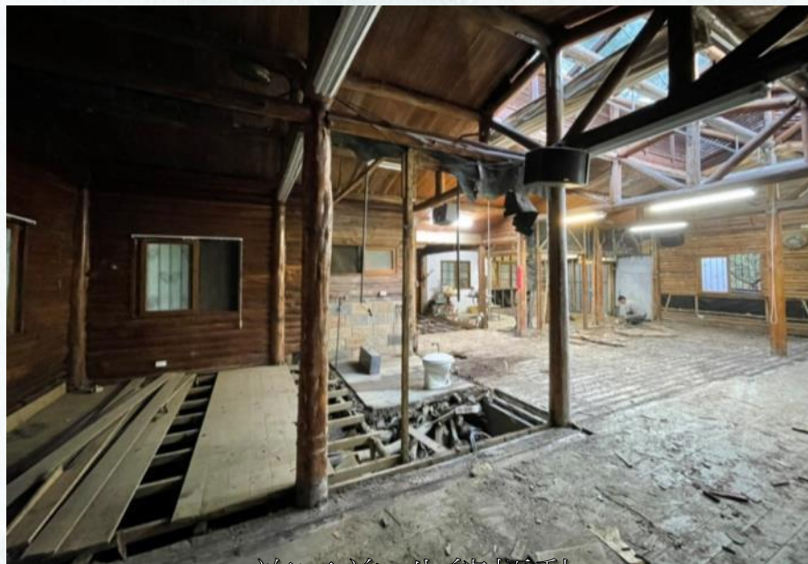
施工前 生態擾動
