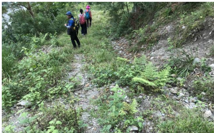
步道鋪面、排水及休憩設施缺乏整體性設計，雜草叢生以致使用率低
