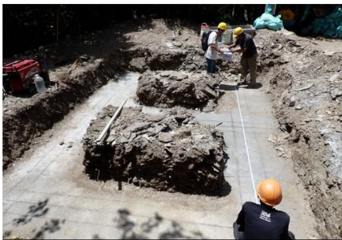
基礎開挖檢查
