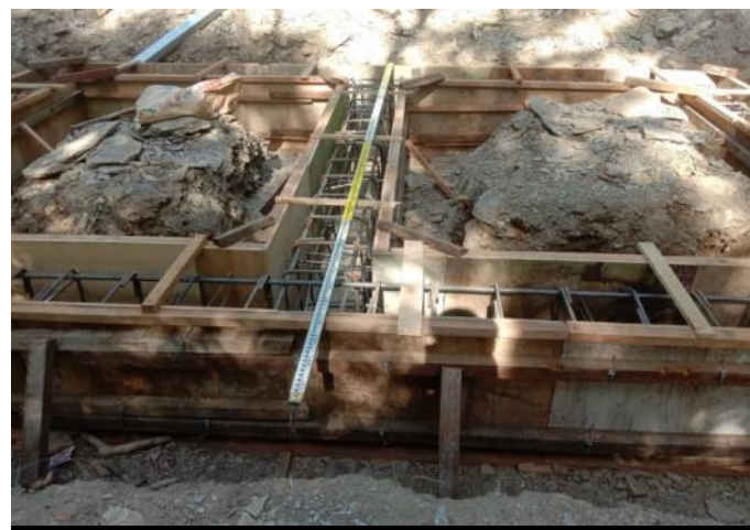
地樑鋼筋綁紮與模板組立檢查
