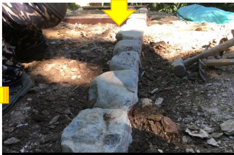
階梯封邊石施作
