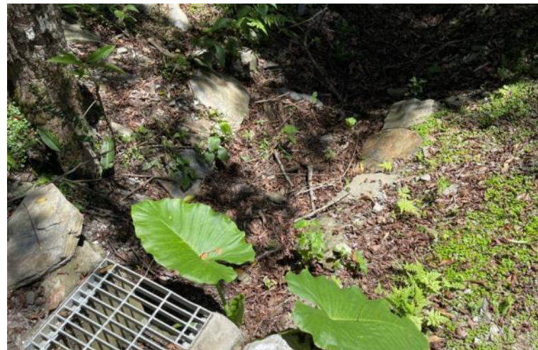
消能疊石避免水沖刷下邊坡
