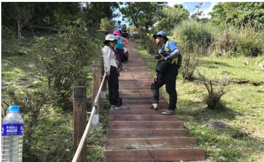
好漢坡步道坡度過陡，影響遊客使用安全
