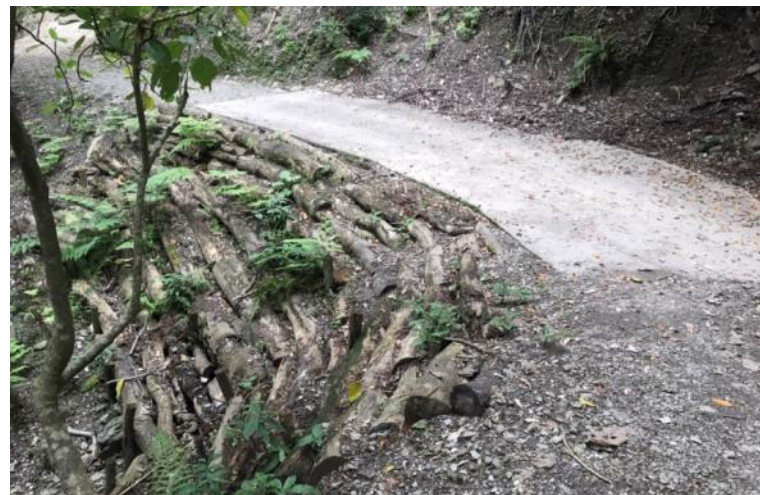
就地取材 - 運用現地倒木，植物可由孔隙處生長
