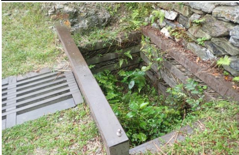
設施具孔隙提供植物生長，小昆蟲、兩棲、爬蟲逃脫
