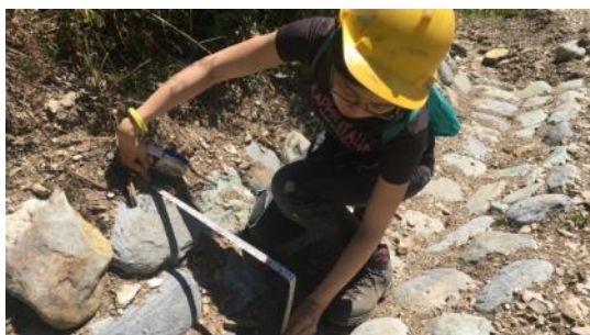
砌石溝施工抽查
